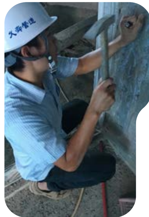
與業主和工程師小胡一起查驗砂氯離子含量 親自動手下去打牆上土渣
