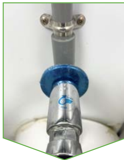
建案工地使用省水裝置
